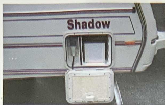
バッテリー&AC100V電源入カコード
